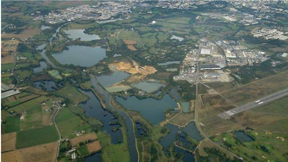
Figure 35 : Gravières du Sud de Rennes ( www.ouest-france.fr )
