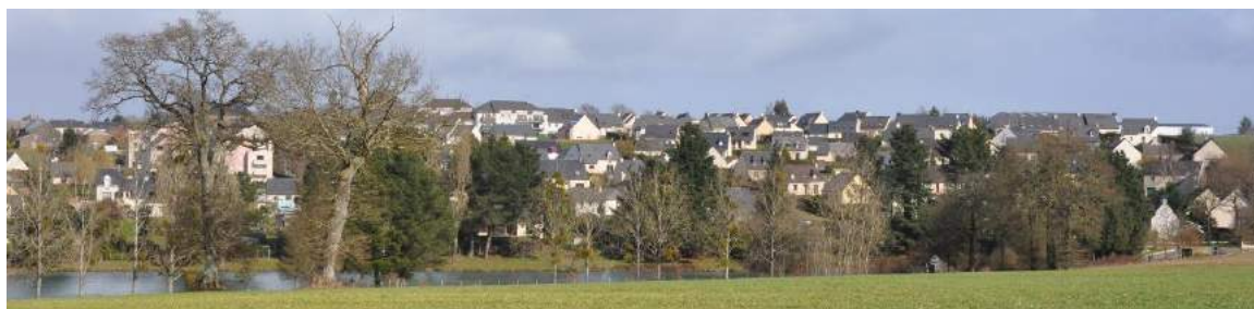
Extensions urbaines pavillonnaires à Crevin – hiver 2015
